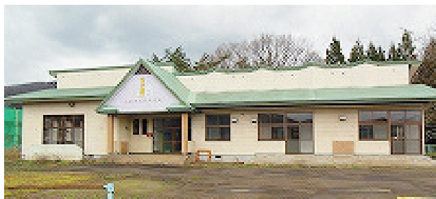
旧葛原保育所。平成21年3月に閉所後、空き公共施設になっていた
