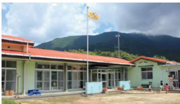
旧保育所を改修した、みまきガーデンの外観
