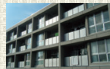
市独自の基準に基づき整備された市営住宅
