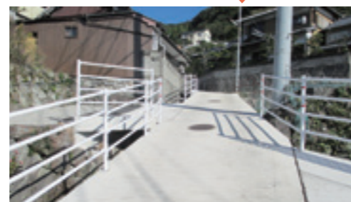
不便な階段の解消により自動車などが通行できるようになり、住民の利便性向上を実現した道路(整備後)
