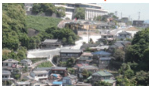
不必要な迂回路の解消により直線に近い形で整備を行い、住民の利便性向上と道路整備費の縮減などを実現した道路(整備後)
