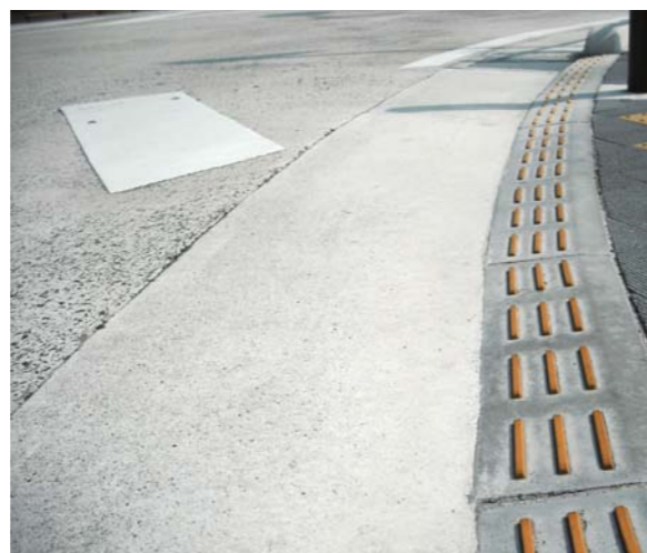
歩道の段差が縮小され、円滑に移動できるようになった段差(条例施行後)
