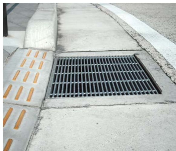
目の細かい構造となり、杖などが落ち込まなくなった排水溝の蓋(条例施行後)
