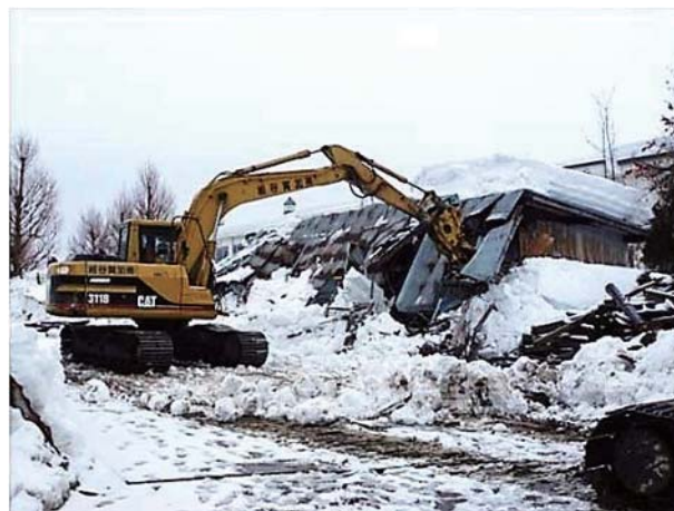
行政代執行による解体工事
