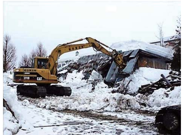
行政代執行による解体工事
