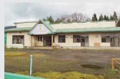
閉所後、放置されていた旧保育所
