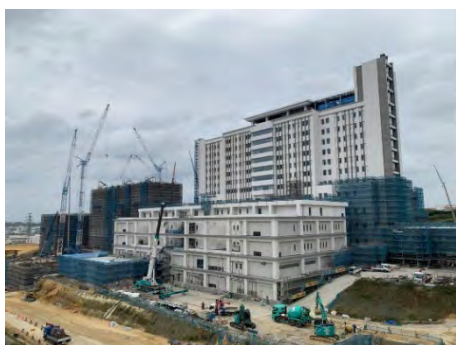
移設先での大学病院整備状況 (令和6年3月)(宜野湾市)
