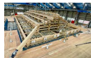
首里城正殿の復元整備状況 (令和5年12月25日現在)
