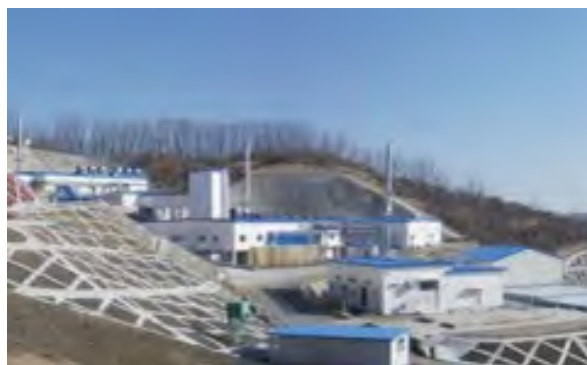
ハルバ嶺発掘・回収施設
