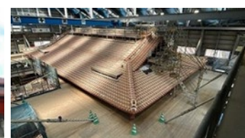
首里城正殿の復元整備状況 (令和7年3月25日現在)
