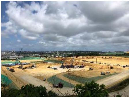
移転用地の現況（令和 3 年 4 月 5 日現在）（宜野湾市）
