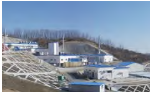
ハルバ嶺発掘・回収施設
