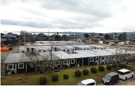
令和6年能登半島地震における応急仮設住宅 (写真提供：石川県)
