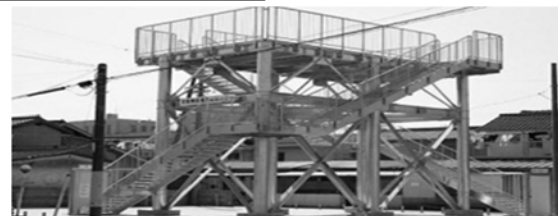
【津波避難施設】
