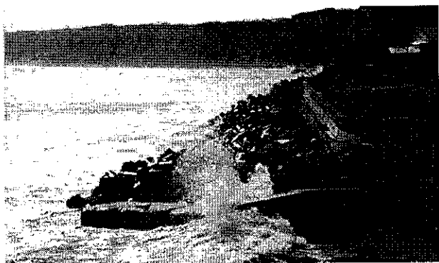
集落の前面において越波が発生(平成元年)
