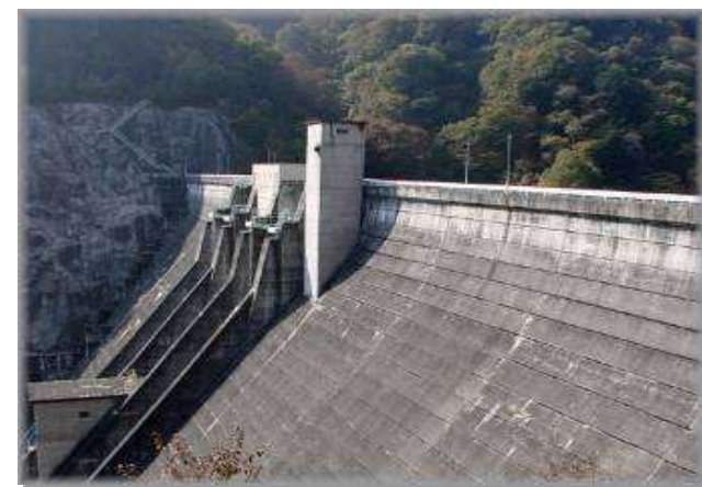
水力発電所(中部エリア)1,200kW
