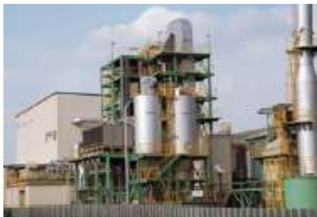
バイオマス発電所(東京エリア)1,250kW
