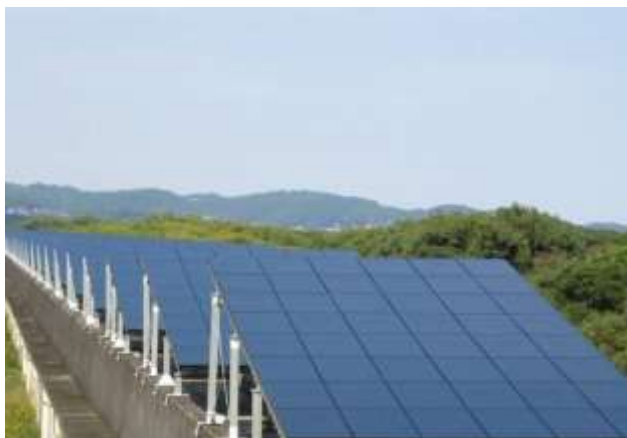
太陽光発電所(九州エリア)1,000kW
