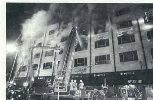
〈大阪千日デパートビル火災の状況〉
