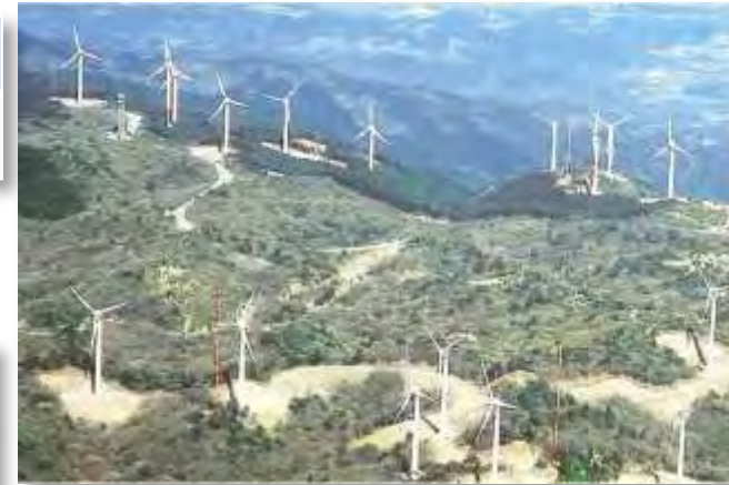
● 風力発電施設用地による保安林解除事例 (三重県)
