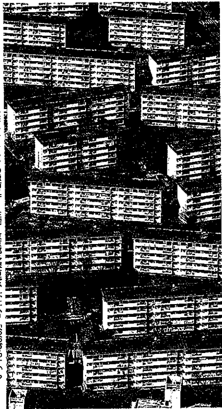
建て替えが決定された多摩ニュータウンの諏訪二丁目住宅。東京都多摩市で、本社へ「おはよう」から
