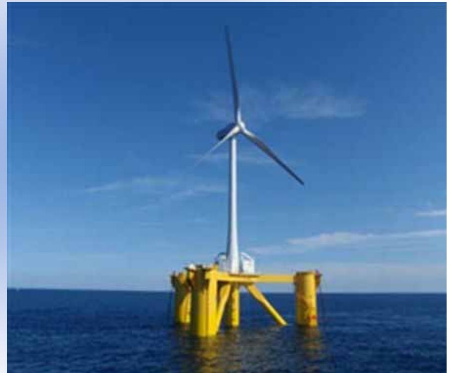
浮体洋上風力発電設備 (福島沖、11月10日運転開始)
