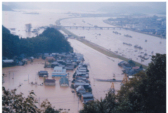
平成16年台風第23号による被害（円山川の破堤により浸水した豊岡市内） 写真提供：兵庫県豊岡市 Damage caused by Typhoon 23 in 2004 (Hyogo) Photo: Toyooka City, Hyogo Prefecture
