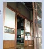
耐震補強工事の一例 Earthquake-proofing
