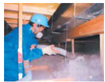
天井の断熱改修
