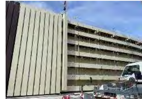
防潮堤かさ上げ工事
