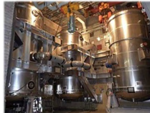
フィルタベント系設置工事
