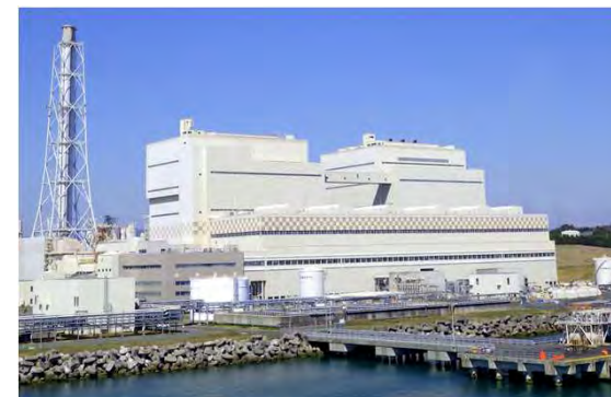
原町火力発電所
