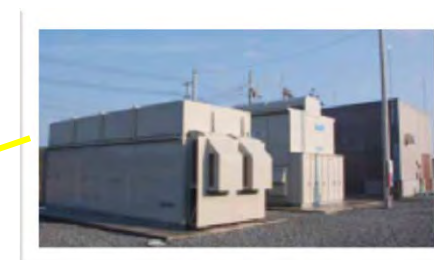
NAS電池 (1,500kW)
