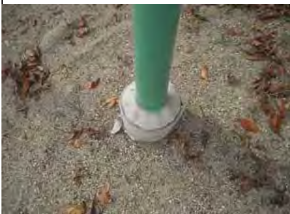
基礎突出状況
