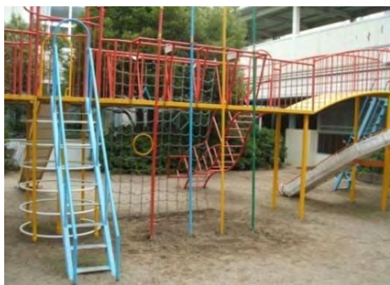
複合遊具での転落事故現場
