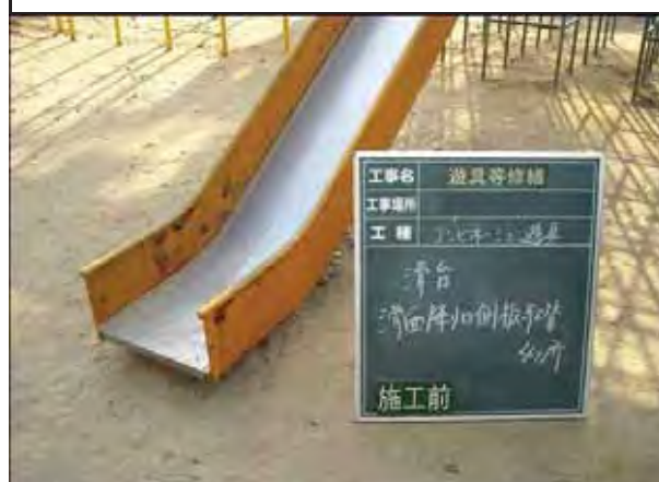
修繕前 (滑台側板)
