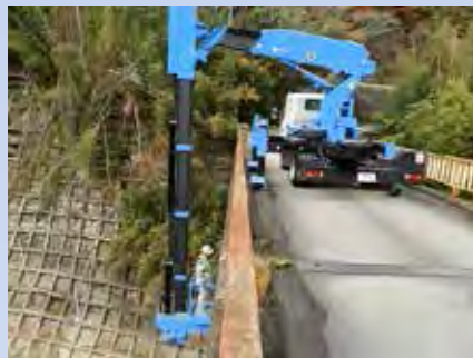
I桁部は橋梁点検車
