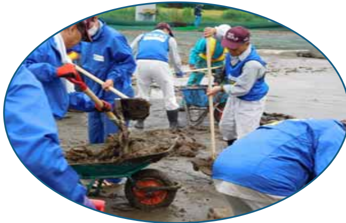
土砂搬出作業
