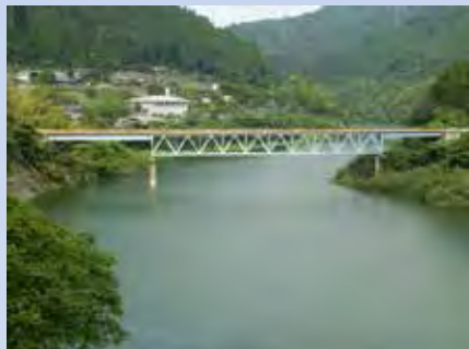
橋長120mの市道橋(全景)
