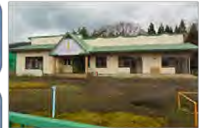
閉所後、放置されていた旧保育所
