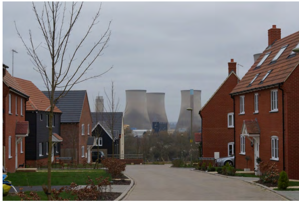
火力発電所(間もなく運転中止)
