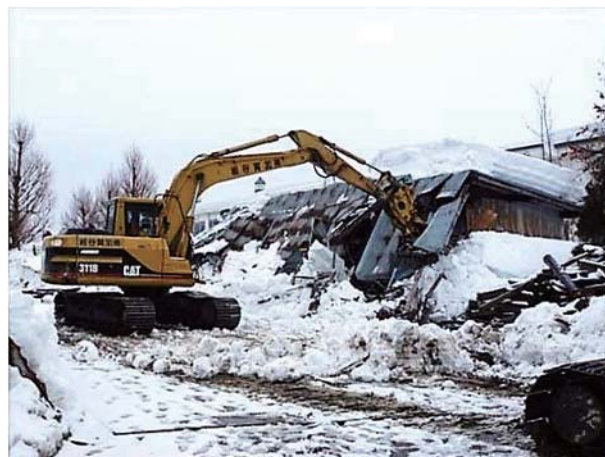
行政代執行による解体工事
