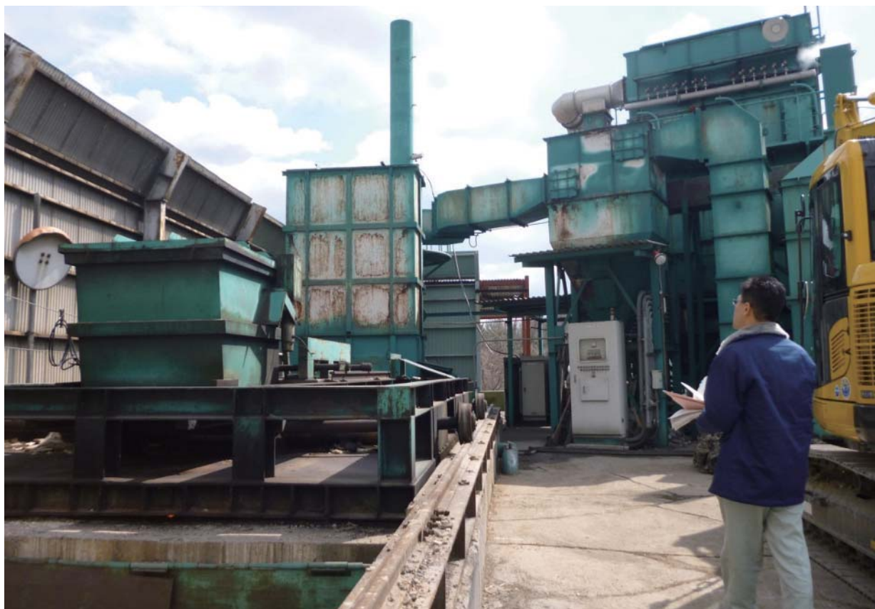
地区内の規制対象施設（焼却炉）
