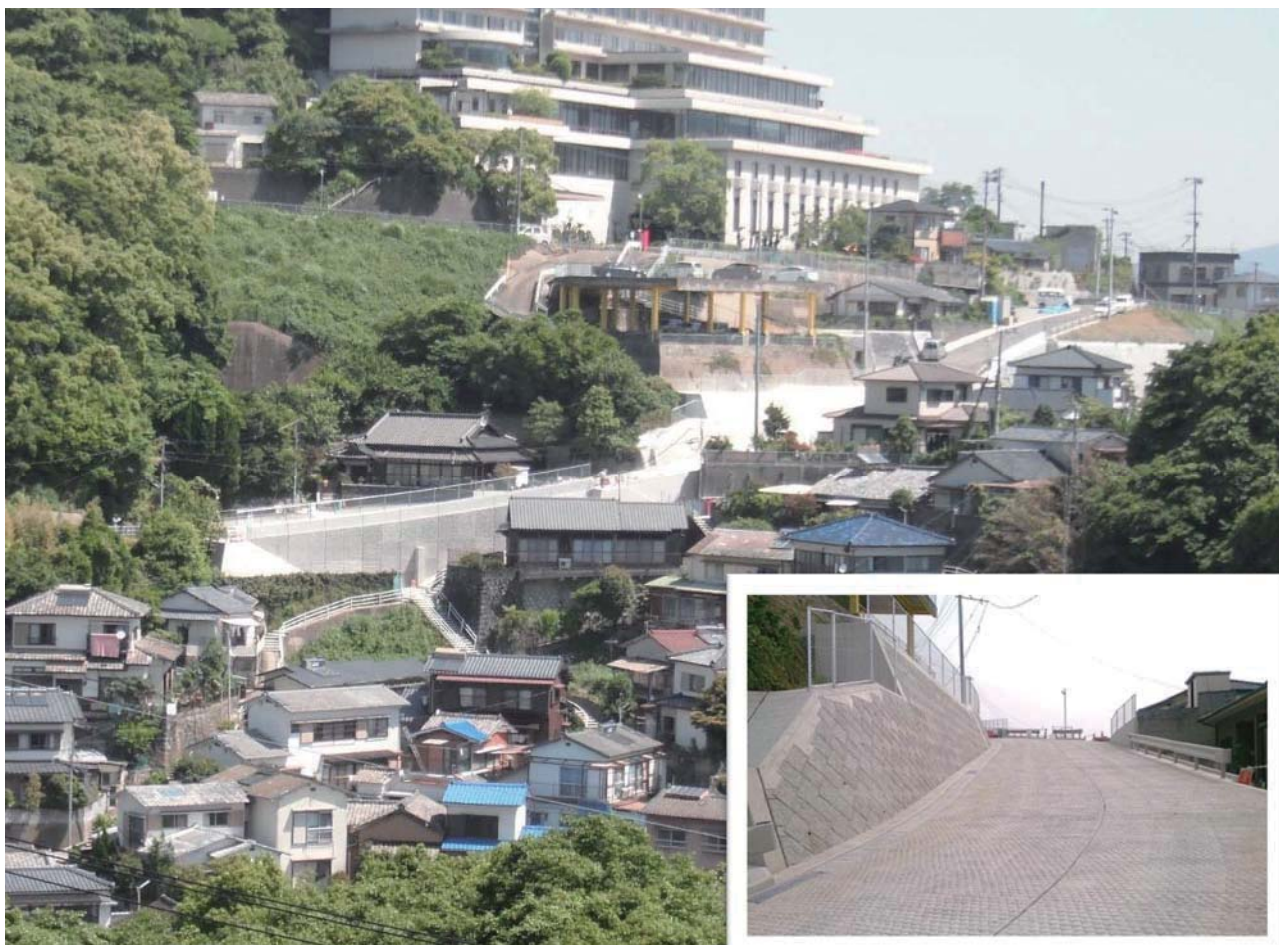
新たな基準で整備された市道大鳥町大谷町1号線（延長79m、縦断勾配最大16.889%）
