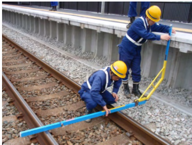
駅施設完成検査
